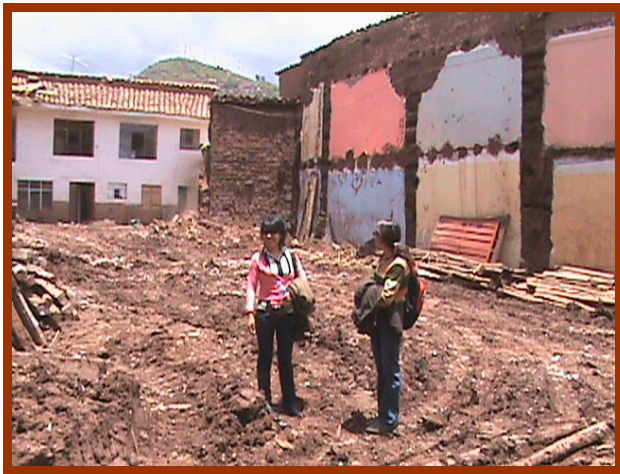
Dolores en Flor inspecteren de sloop.
