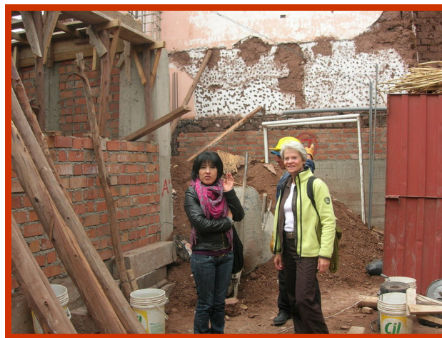
Marianne en Dolores inspecteren de bouw.
