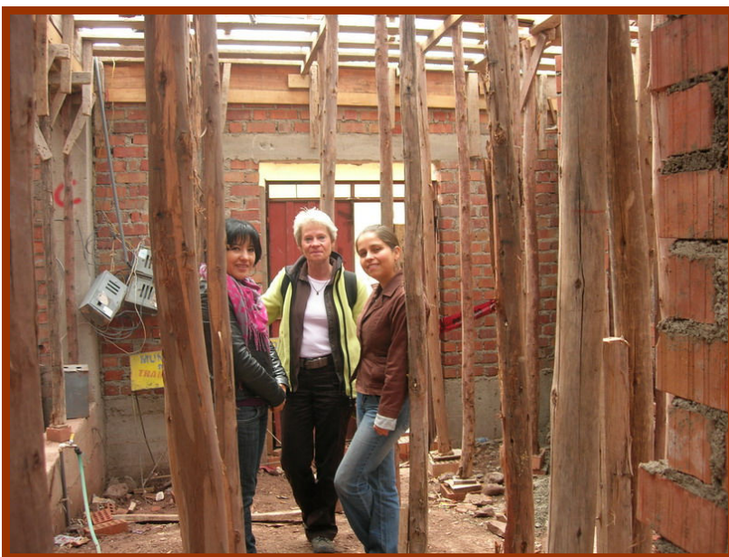
Dolores, Marianne en de architecte Blenda bewonderen de bouw.
