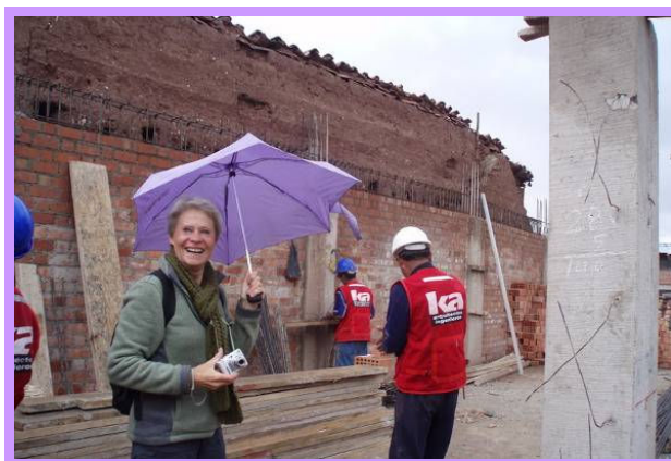
'Opzichter' Marianne inspecteert de bouw.
