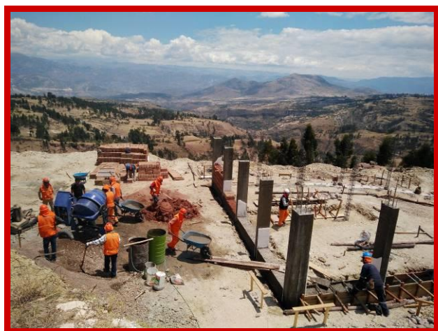
Op 1 september is Mama Alice met de bouw gestart.
